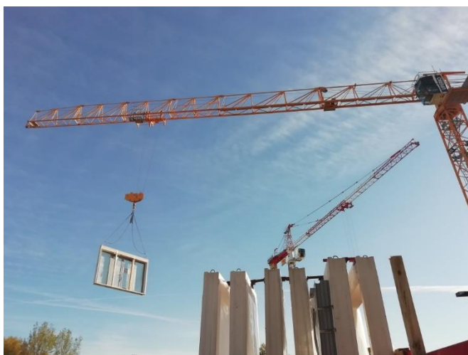
Grutage d'un Bloc baie béton sur mesure
