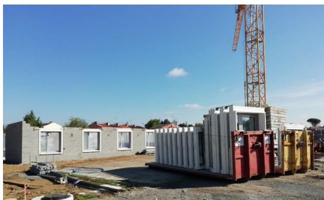
Stockage des Blocs baies avec modénature avant étape de pose
