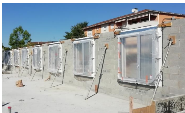
Blocs baies béton Linea+ dans la maçonnerie avant clavetage
