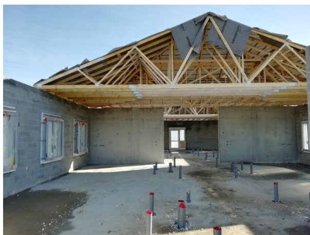
Avancement du chantier bientôt hors d'air
